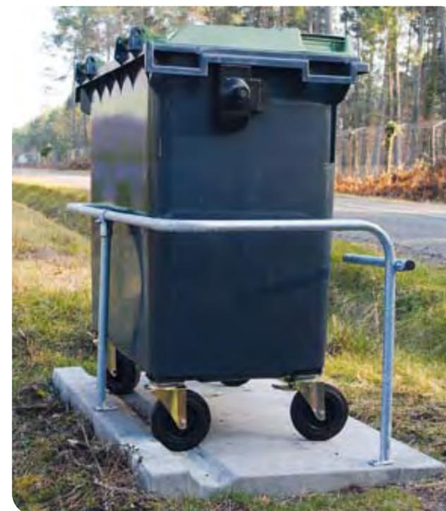
Socle en béton armé, compacté et vibré
