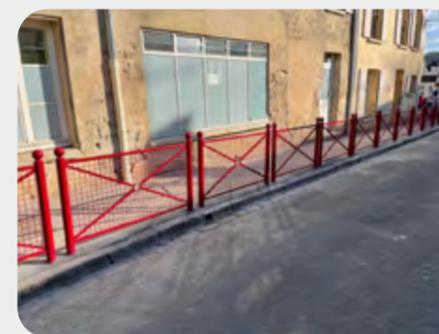
Beaucoup de nos barrières peuvent être associées avec du grillage afin de garantir une sécurité supplémentaire sur le bord des trottoirs ou près des écoles. Le grillage est posé par soudure sur la barrière pour permettre le maintien et éviter l'arrachement de celui-ci.
